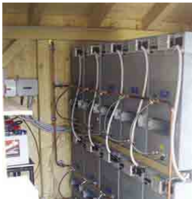
Auf der Schutzhütte „Radsee“ wird der Strom seit 2003 aus H 2 erzeugt. Die praktisch lautlose 10-kW-Brennstoffzelle produziert dabei reinen Wasserdampf und ersetzt das auf Schutzhütten derzeit verbreitete laute und stinkende Dieselaggregat. Ob und wie H 2 -Brennstoffzellen-Systeme für das harsche Klima im Gebirge angepasst werden müssen, wird das wissenschaftlich begleitete Pilotprojekt zeigen.
