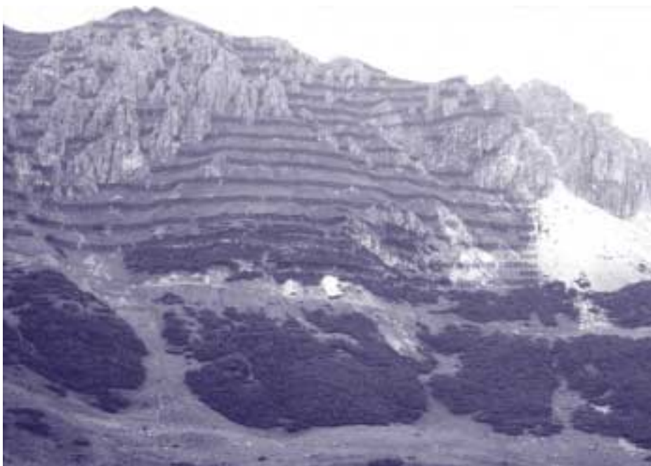
Lawinerverbauungen im Bereich der Kaserstättalm zum Schutz des Fremdenverkehrsortes Neustift im Stubaital
