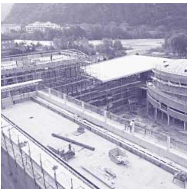
Sonnenkollektoren auf den Dächern des neuen Akademie-Gebäudes sorgen für eine umweltfreundliche Klimaanlage
