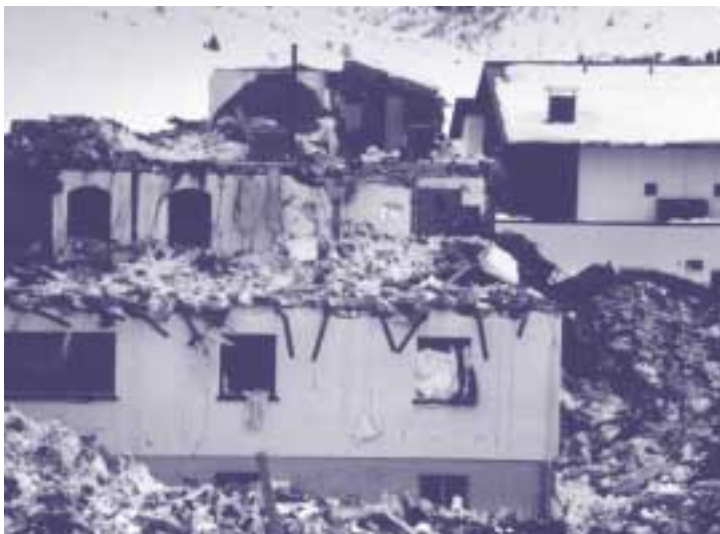
Die Zerstörungskraft einer Staublawine am Beispiel eines Hauses im Zentrum von Galtür (1999)
