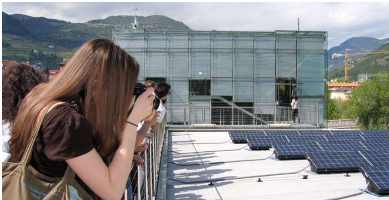
Lokalausgleich der Fotovoltaikanlage auf dem Dach der EURAC.
