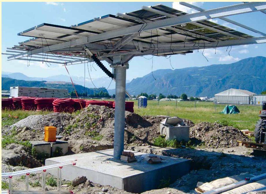
Il cantiere all'aeroporto di Bolzano.
