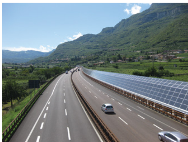
Abbildung 25: Photovoltaik-Schallschutzwand an der Brennerautobahn bei Isera
