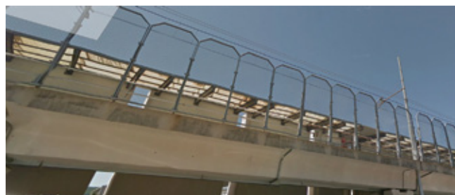
Abbildung 23: Bahnhof Bozen Süd, Überdachung über der Zügeinfahrt.
