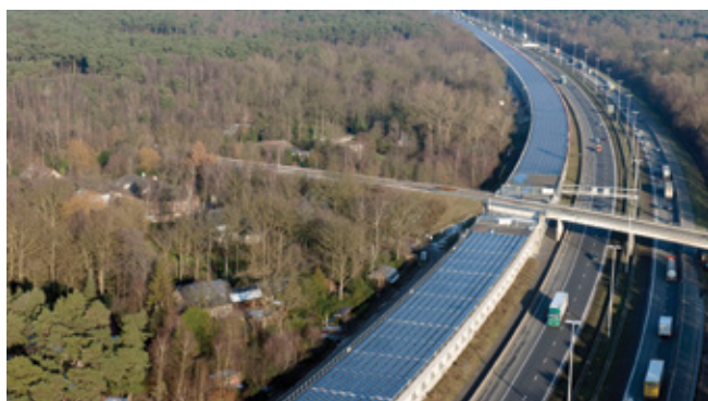
Abbildung 24: „Solar“-Tunnel als Gleisabdeckung bei Antwerpen.
