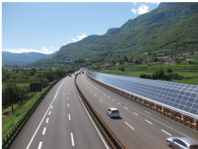
Figura 25: Barriera antirumore fotovoltaica installata nei pressi di Isera lungo l'Autostrada del Brennero (Fonte: Autostrada del Brennero SpA)
