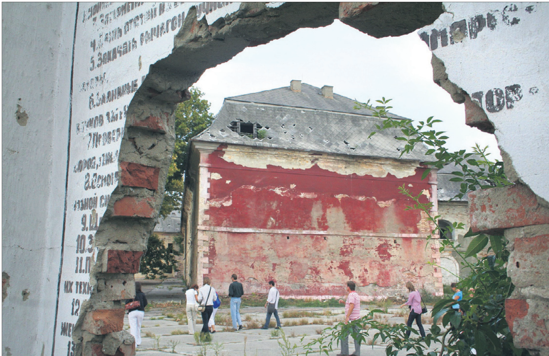
Här och där finns text som skvallrar om fortets funktion. Efter att sovjetsoldaterna flyttade ut år 1991 togs fortet i bruk av den slovakiska armén. Nu närmast väntar de utrymda byggnaderna på en rejäl upprustning och ett eventuellt framtida bruk som en kulturinstitution. Redan i dagstället lockar fortet besökare från närregionerna och Tjeckien. FOTO: KENNETH MYNTTI
