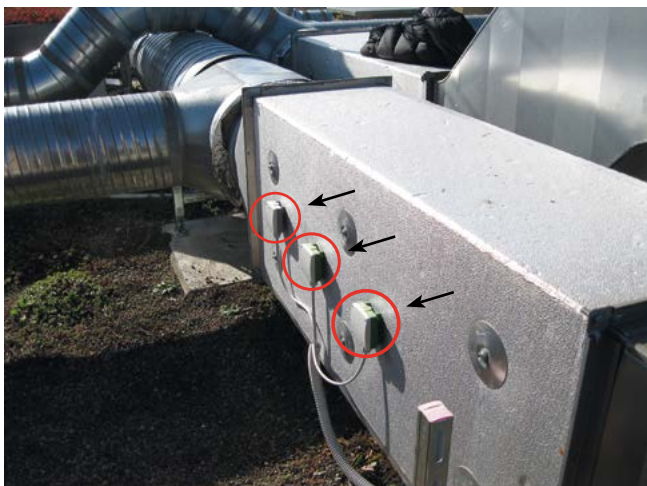
Figura 170: Sensori di temperatura, umidità, velocità dell'aria, CO 2 montati in un canale di ventilazione dell'edificio EA5
