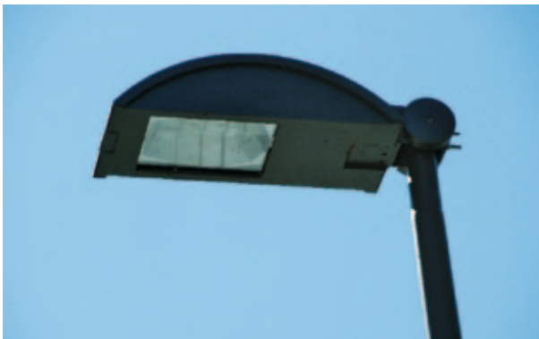
Abbildung 21: Full-cut-off-Leuchte
